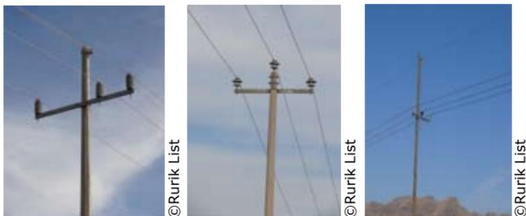
Diferentes tipos de estructuras tangentes trifásicas
